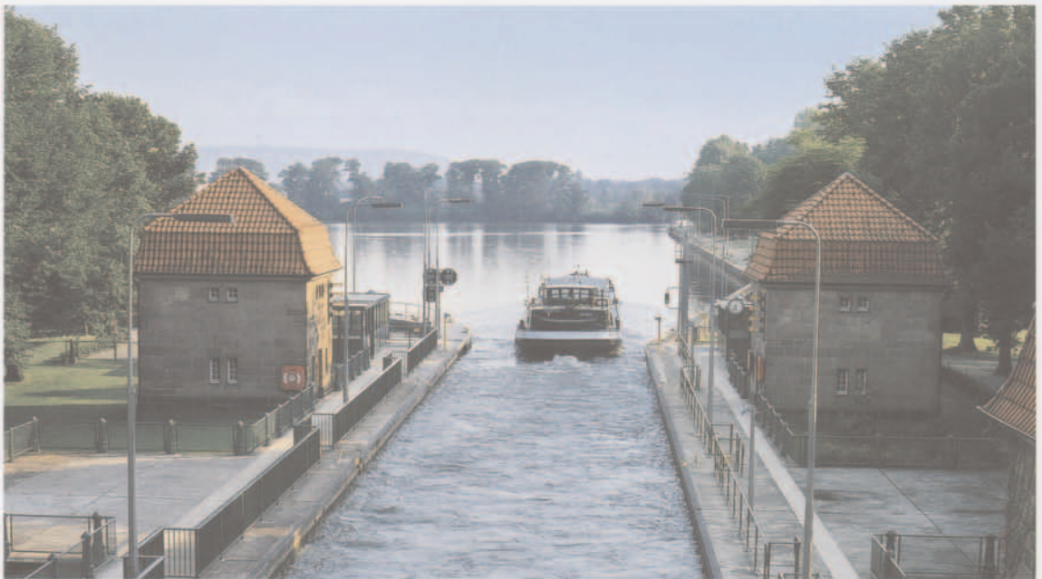
Ausfahrt aus der Schachtschleuse in den Mittellandkanal
