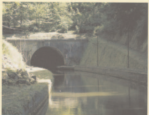
Einfahrt in den Tunnel von Niderviller
