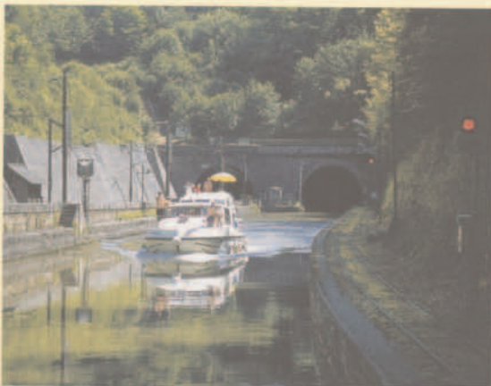
Im Tunnelfenster bei km 249
